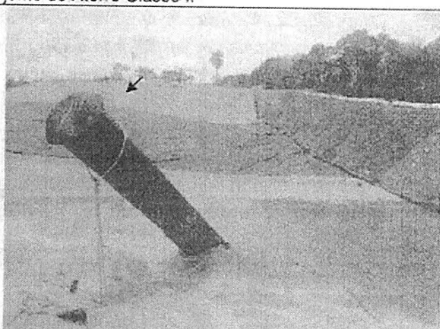
Foto 8 – Vista parcial da área do Aterro Classe I – detalhe para o dreno testemunho.
