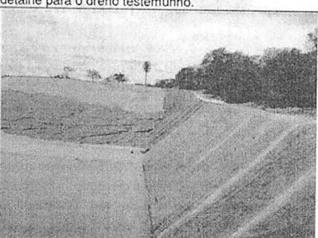
Foto 10 – Vista parcial da área do Aterro Classe I detalhe para o recobrimento impermeabilizante por geomembranas em PEAD.
