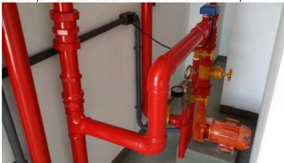
Figura 1 - Exemplo de Instalação da Bomba de pressurização
