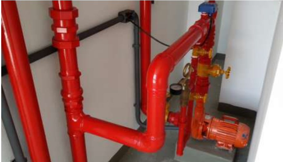
Figura 1 - Exemplo de Instalação da Bomba de pressurização
