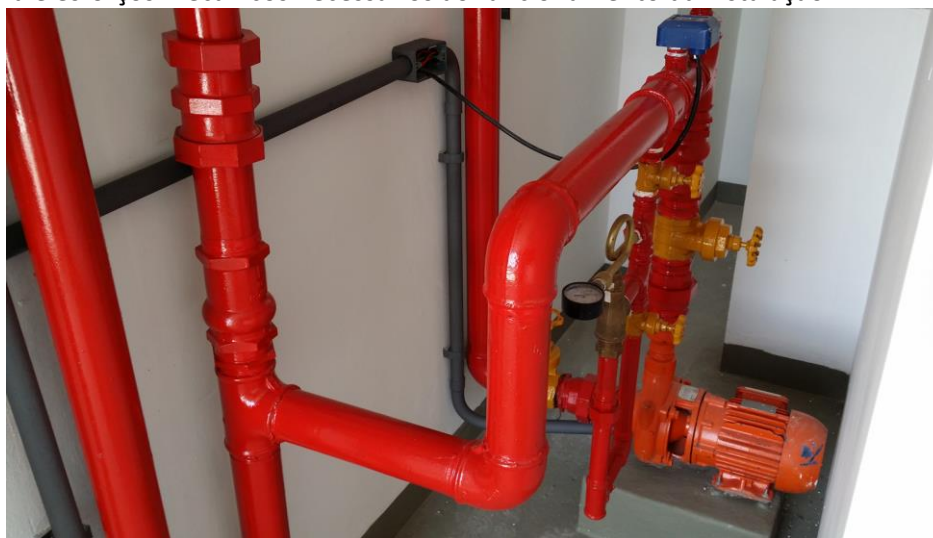
Figura 1 - Exemplo de Instalação da Bomba de pressurização
