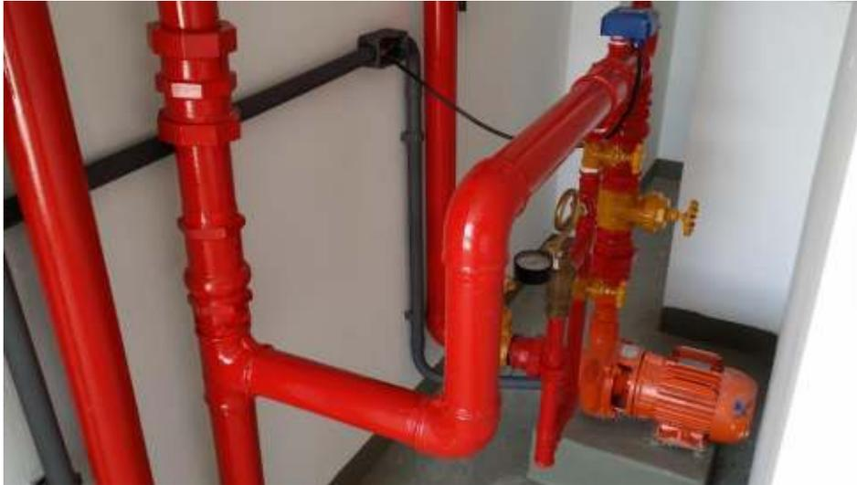
Figura 1 - Exemplo de Instalação da Bomba de pressurização
